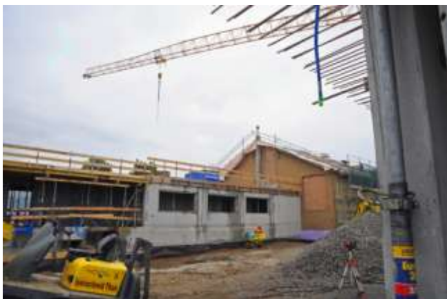
Bild links – Baumeisterarbeiten: Die Baumeisterarbeiten wurden Ende Oktober beendet.
