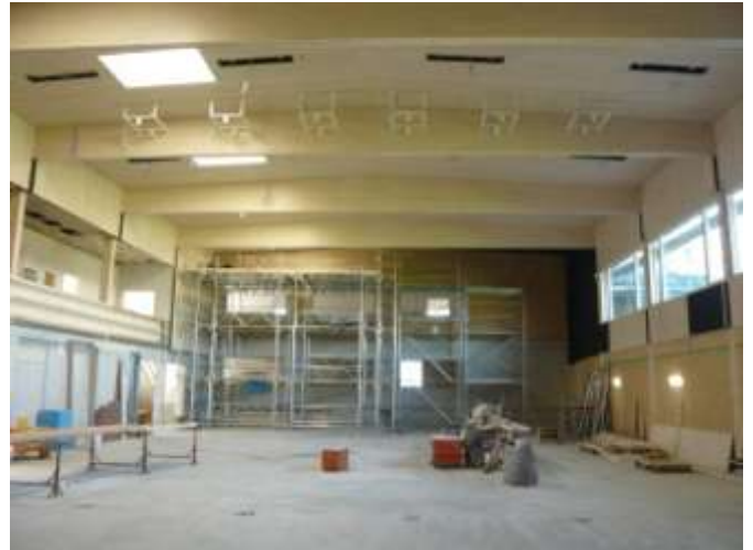
Neubau der Turnhalle von innen.
