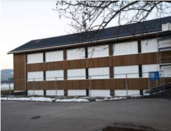
Altbau-Teil des OSZ Unterlangenegg von aussen saniert
