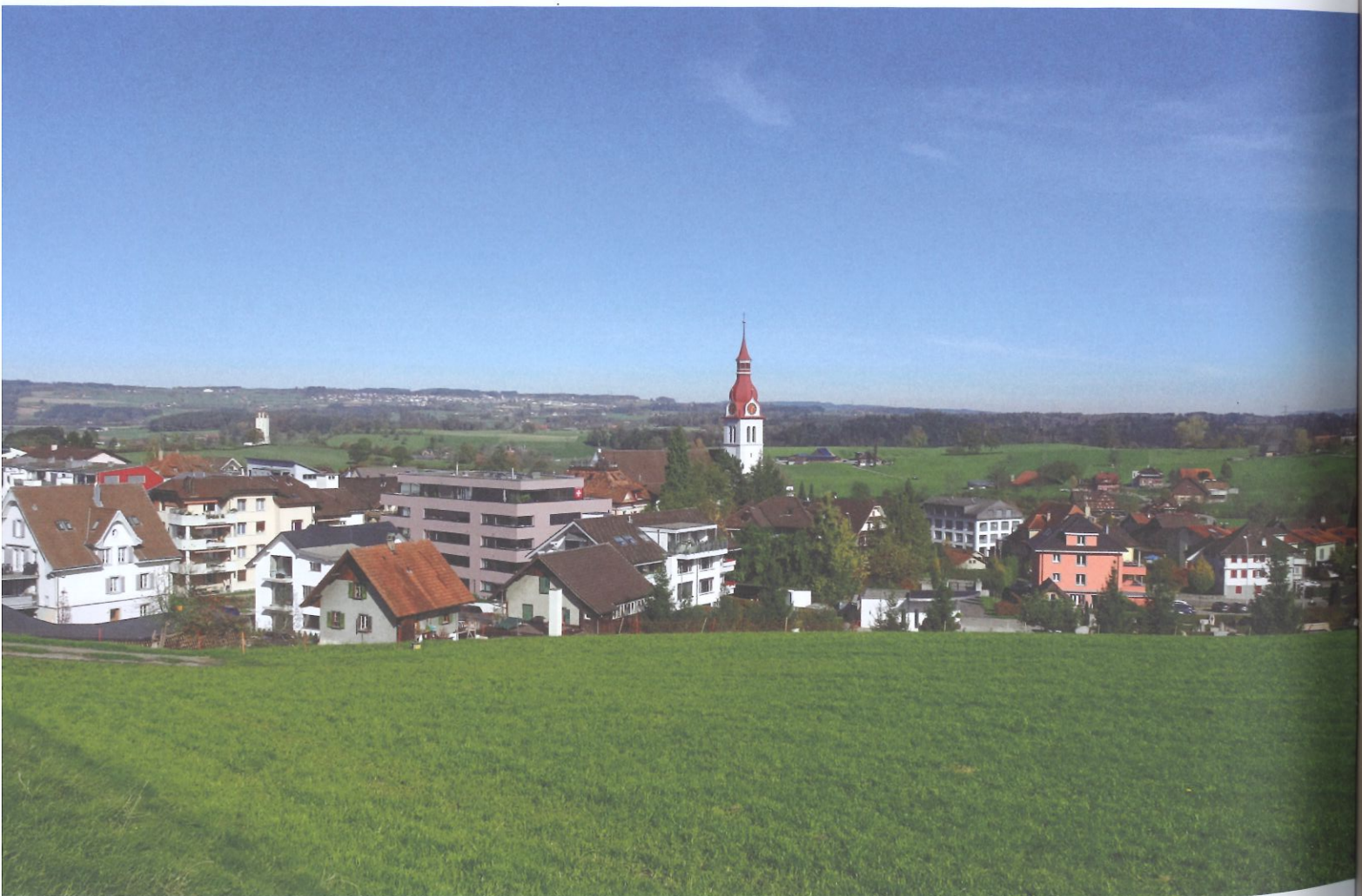
Illegale Bauten ausserhalb der Bauzone in der ländlich geprägten Gemeinde Neuenkirch LU führten zum wegweisenden Urteil des Bundesgerichts zur Verwirkungsfrist. Foto: Pius Achermann, Neuenkirch
