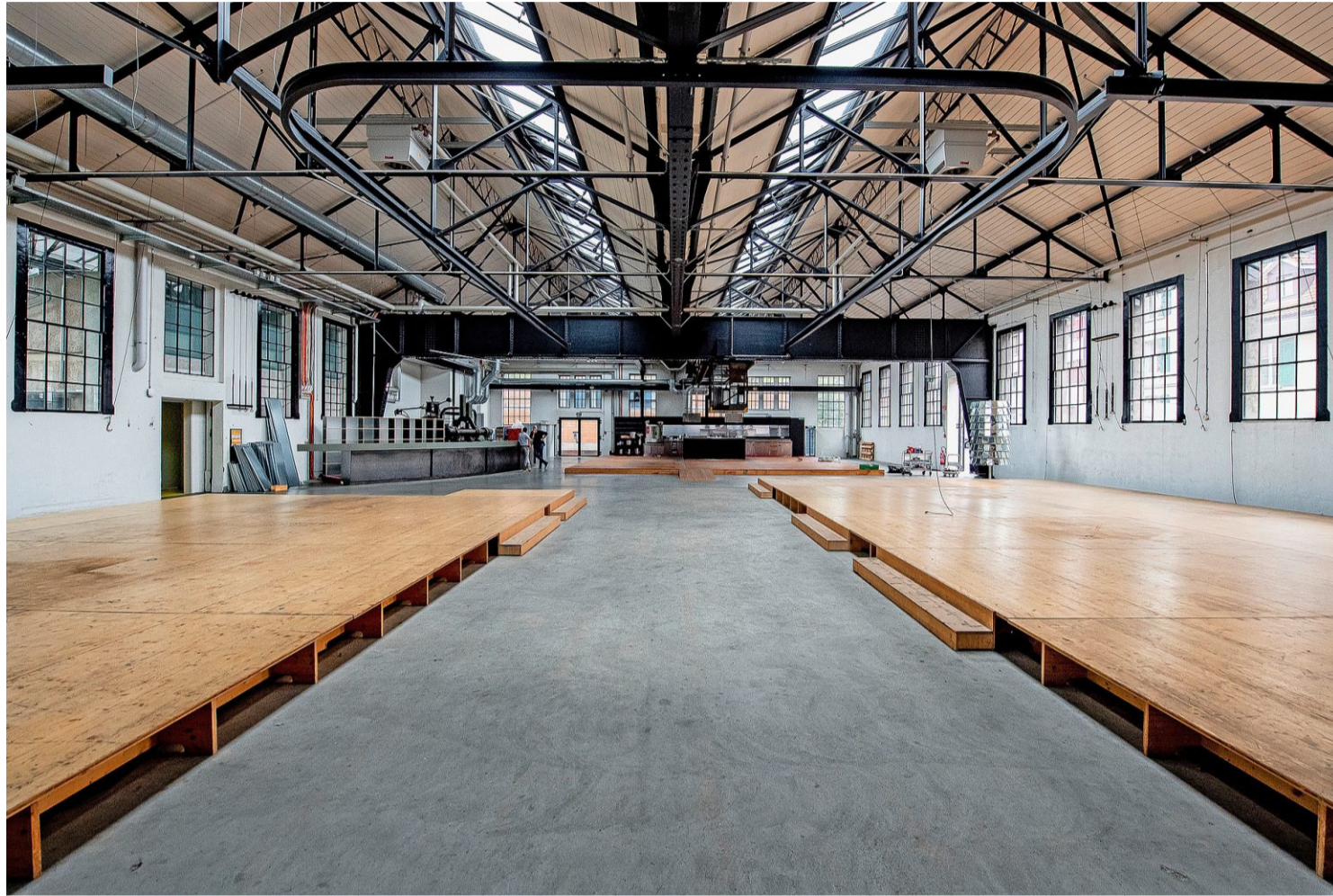
Die Halle 6 im Selveareal ist weitgehend leergeräumt. Die Stadt Thun hat die Podeste, die Lüftung und die Gastro-Infrastruktur aus der Konkursmasse gekauft. Foto: Patric Spahni
